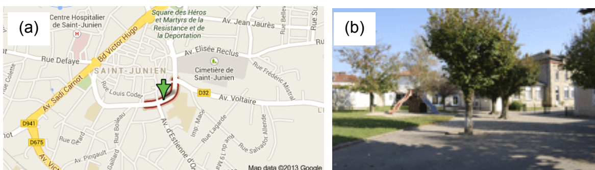
Figure 8 : (a) Emplacement de l'école de Saint-Junien. (b) Photographie de l'établissement.
