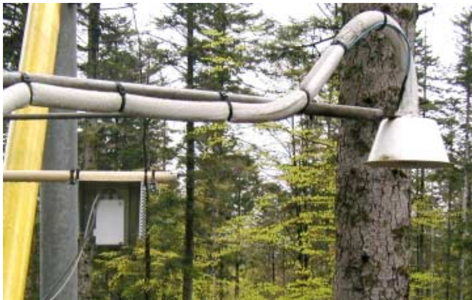
Photo 1 : installation sur la tour du Donon (ASPA)
