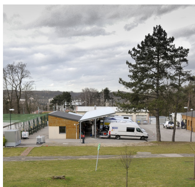
Banc d'essais INERIS - verneuil-en-Halatte (Oise)
