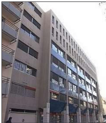
Figure 2.1 : Site de mesure des COV de Marseille
