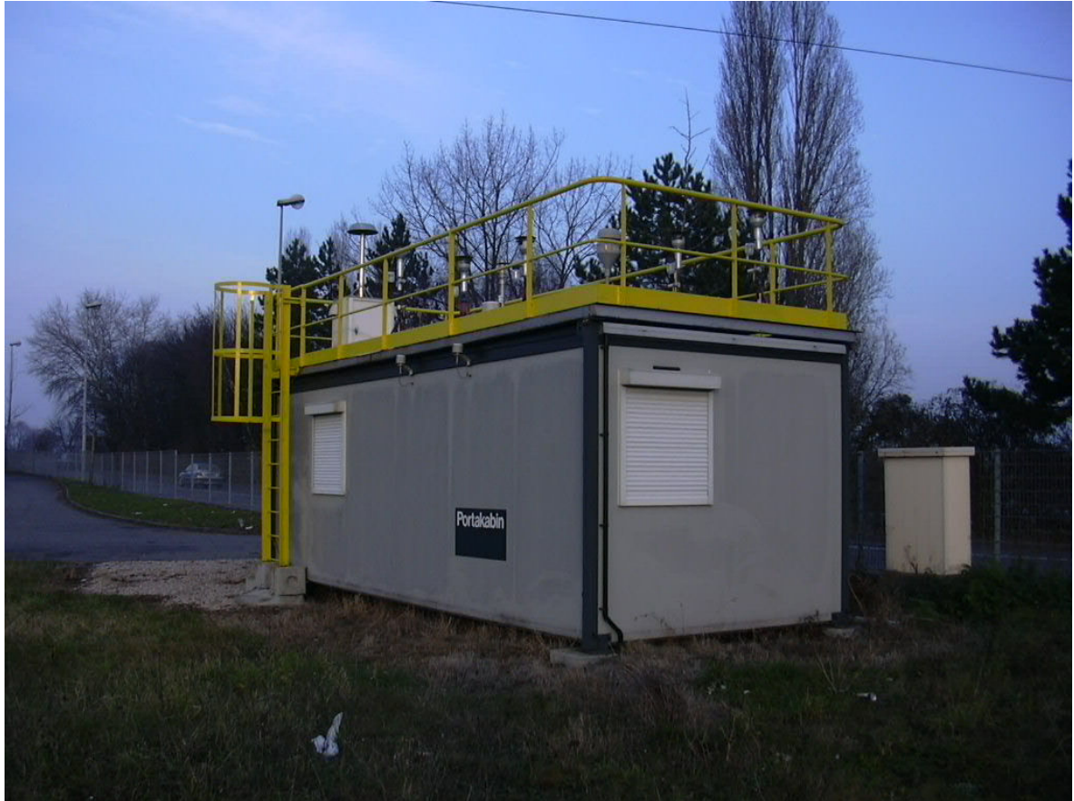
Figure 1: Vue d'ensemble de l'abri autonome sur le site de mesure de l'EMD
