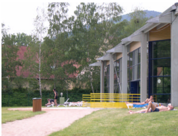
Figure 4: Site de la chaufferie de la piscine
