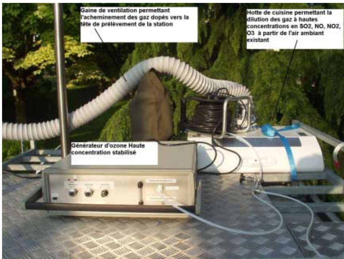
Photo 2.3 : hotte et générateur d'ozone.
