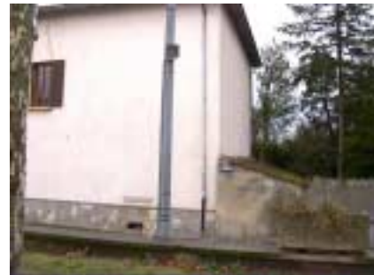
Site de Grenay au centre village (Sud)
