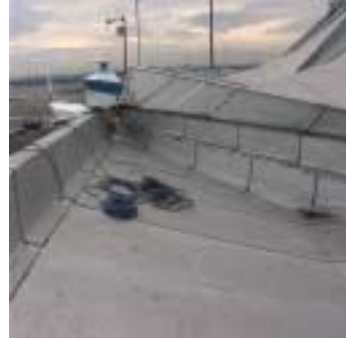
Site Aéroport, Terminal 1, Porte 15
