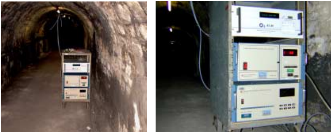
Figure 4 : unité d'évaluation des concentrations dans la galerie
