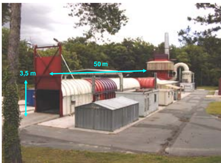
Figure 17 : Photographie de la galerie incendie
