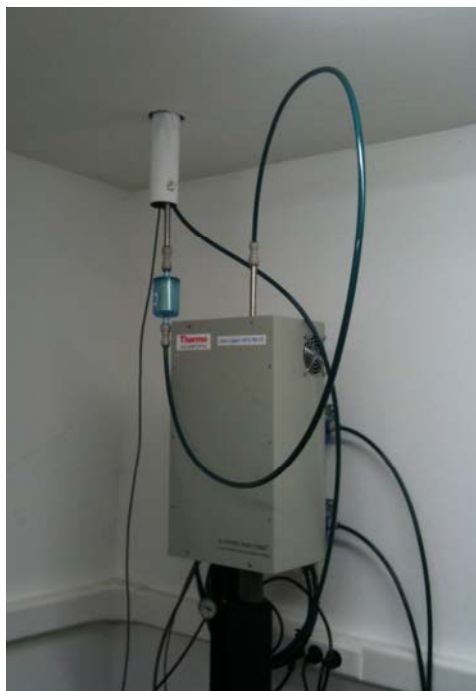
Photo 1 : Réalisation d'un blanc d'instrument
