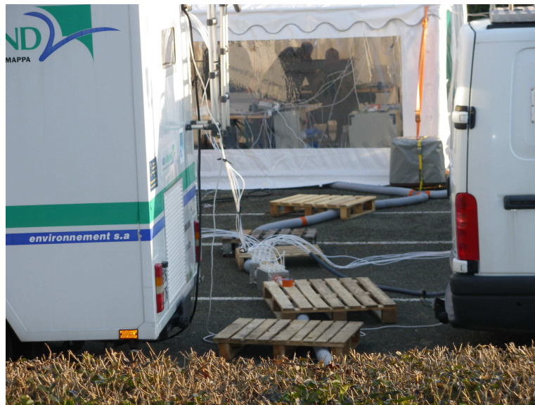
Figure 5 : Vue d'un des axes de distribution d'air dopé
