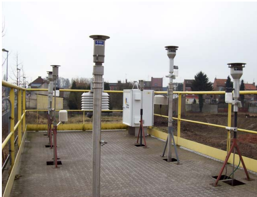
Figure 1: Vues (extérieur & intérieur) de l'abri autonome sur le site de mesure de l'EMD
