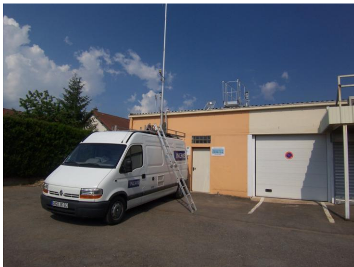
Figure 2 : Vue générale de la station
