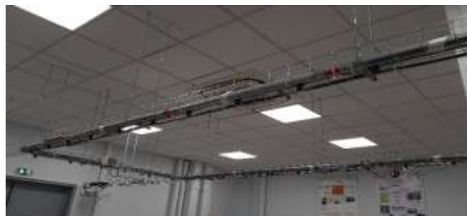
Figure 3 : Ligne de prélèvement spécifique en acier inoxydable traité SilcoNert2000® de 16 m de long et ½" de diamètre.
