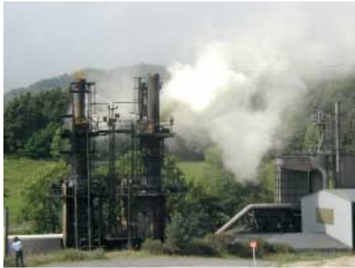
Figure 3. Usine de carbonisation de bois
