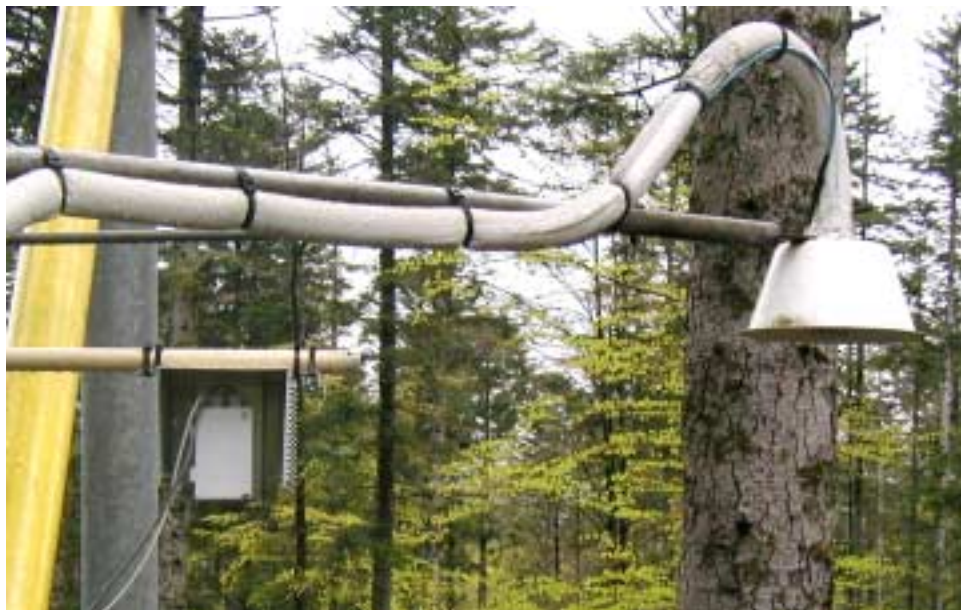
Photo 1 : installation sur la tour du Donon (ASPA)
