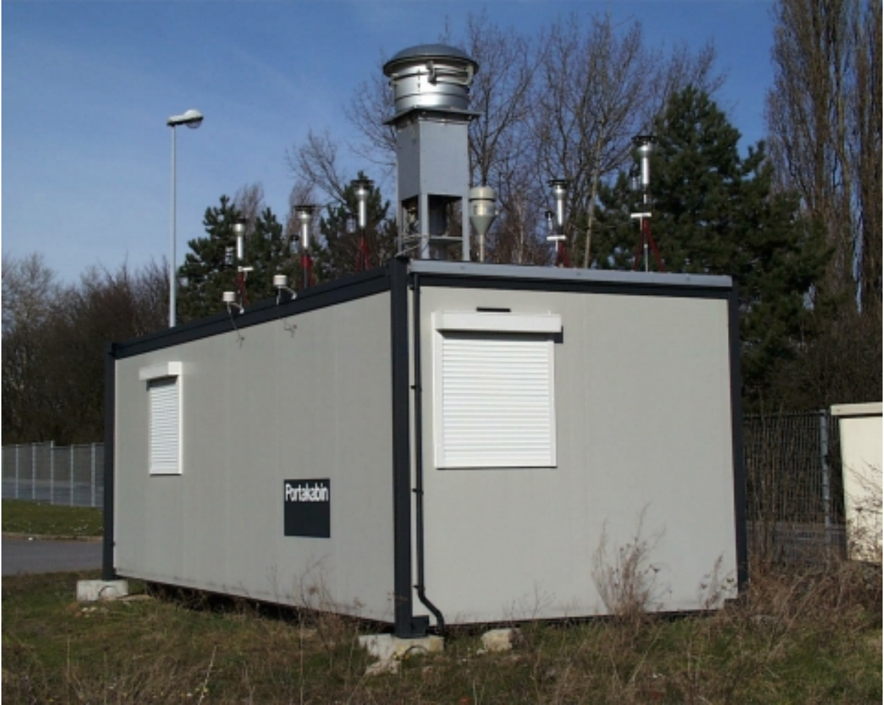
Figure 1: Vue d'ensemble de l'abri autonome sur le site de mesure de l'EMD
