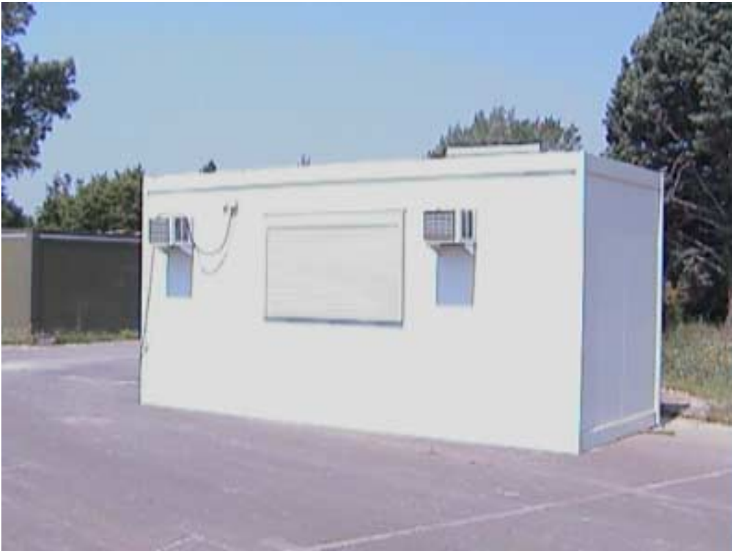
Figure 17 : photographie du LIDAR ALTO installé sur la BA 114 d'Aix les Milles
