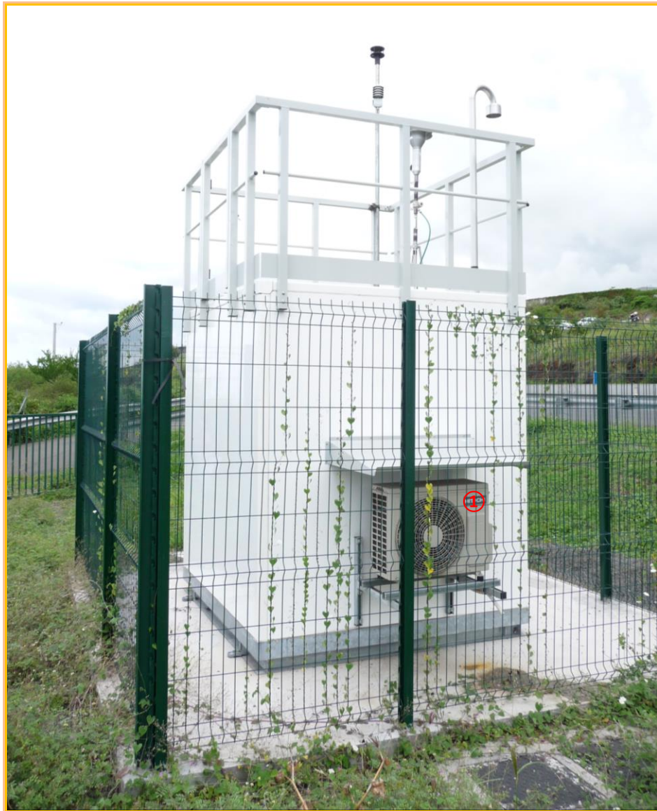
Figure 17 : Emplacement du compresseur de la station RDT.
