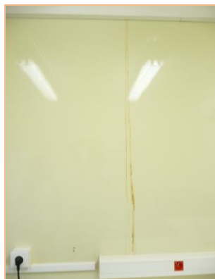
Figure 15 : Infiltrations constatées le long d'une paroi de la station ROY.
