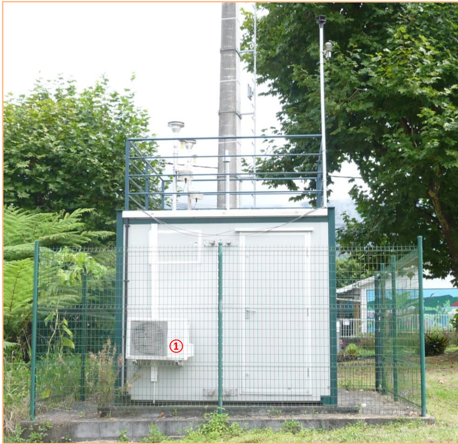
Figure 20 : Emplacement du compresseur de la station GCO.
