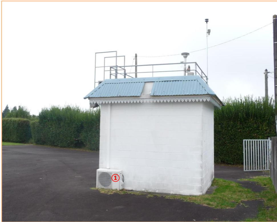
Figure 24 : Emplacement du compresseur de la station BMU.
